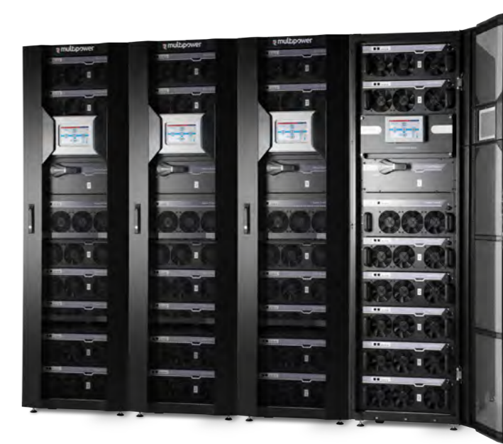
Полностью укомплектованная силовая часть системы из 4-х системных блоков PWC 300
